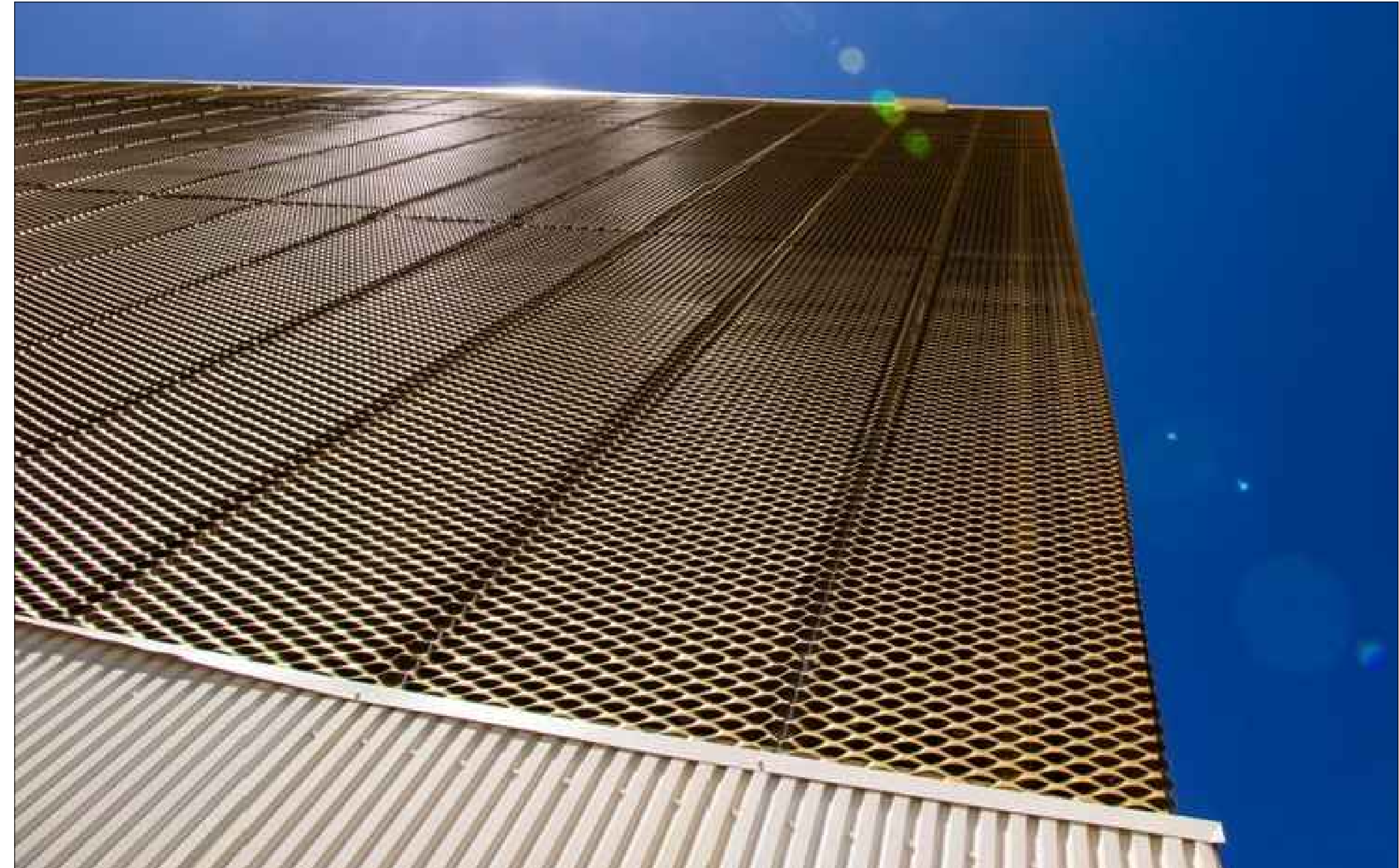
Riferimento rivestimento in lamiera in alluminio tipo Flaminio XS di Fratelli Mariani
